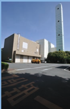
現クリーンセンター
