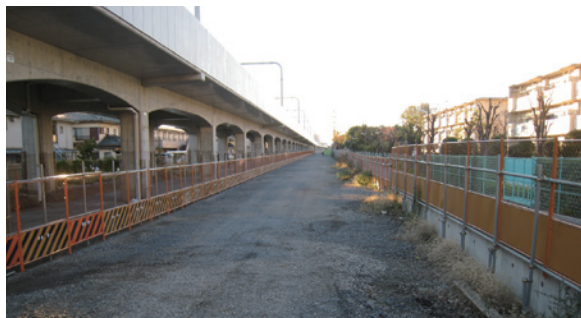
工事が進む現在の側道
