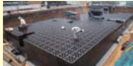
学校の校庭に整備される雨水貯留浸透施設
