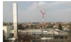
新クリーンセンター建設状況
