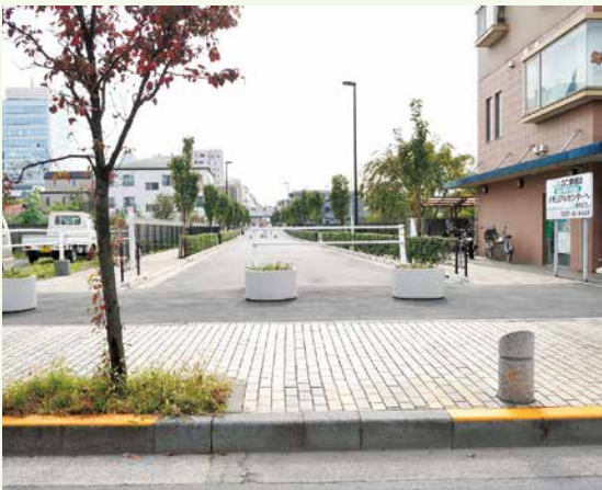
(左) 横断歩道の付近では道路側が盛り上がり、歩道と道路の段差を少なくしている箇所も。(右) 北口駅前広場のブロックは透水性に優れ、雨の日も歩きやすい。
