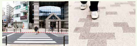
(左) 横断歩道の付近では道路側が盛り上がり、歩道と道路の段差を少なくしている箇所も。(右) 北口駅前広場のブロックは透水性に優れ、雨の日も歩きやすい。
