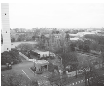
仮囲いを設けた新工場棟建設地
