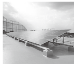
学校屋上に太陽光発電パネルを設置
