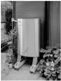
雨水貯留タンク
