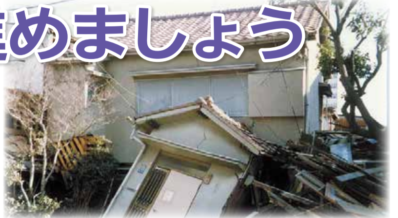
阪神・淡路大震災 家屋被害の様子(出展:一般財団法人消防科学総合センター)
