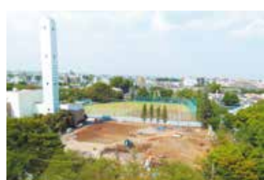
新クリーンセンター建設工事
