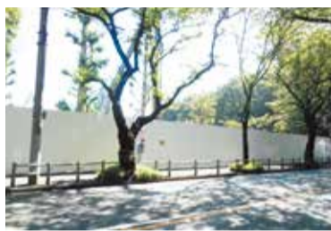
装飾する仮囲い
