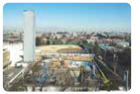
新武蔵野クリーンセンター(仮称)平成29年度の稼働に向け工事中
