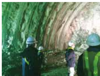
トンネルの現場視察
