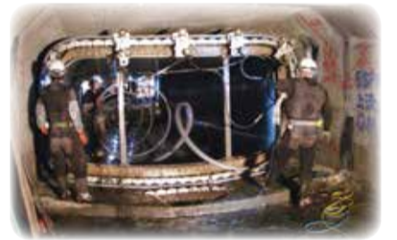
下水道の改修
