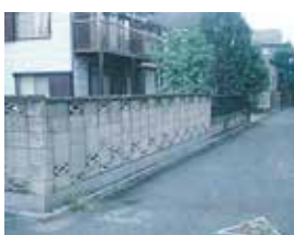
ブロック塀(従前)
