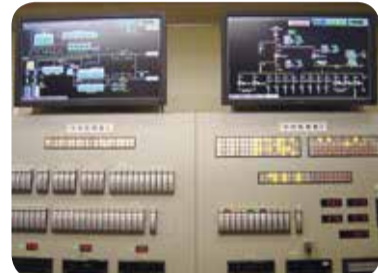
給水量やポンプ圧力を調整する集中管理モニター
