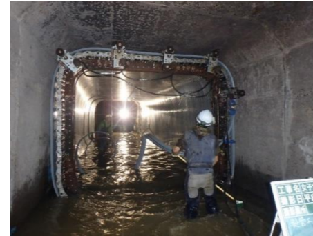
管きょ更生工事の施工状況
