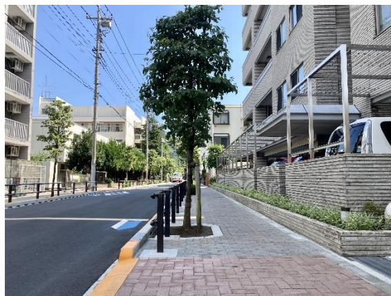
バリアフリーに配慮した市道第73号線
