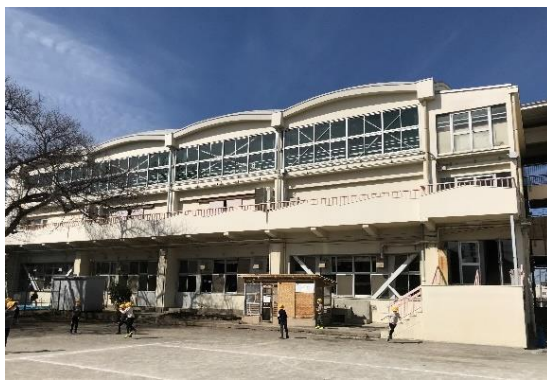
体育館棟外観
