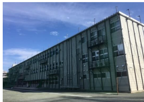
校庭側から見た仮設校舎
