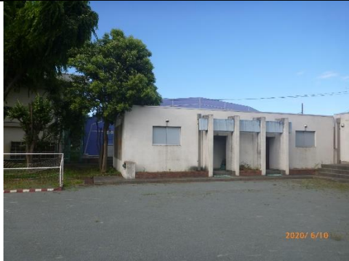
プール更衣室棟
