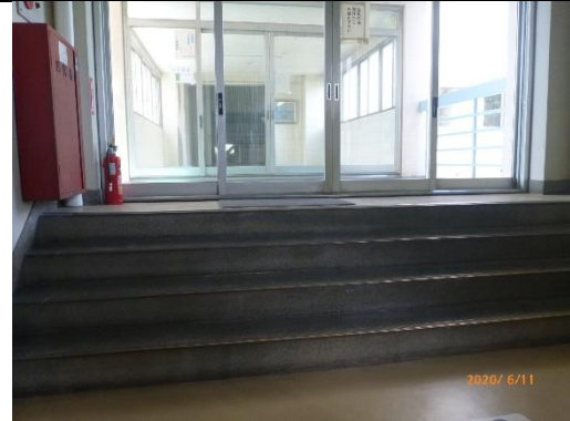
西校舎体育館棟接続部
