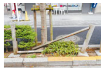
▲防護柵の破損
