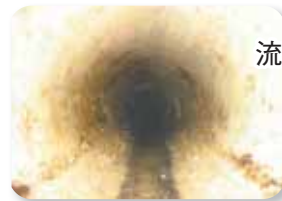
通常時の下水道管内
