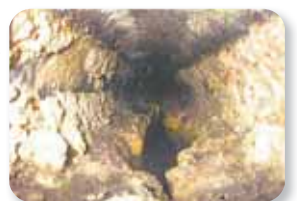
油などが詰まった下水道管内
