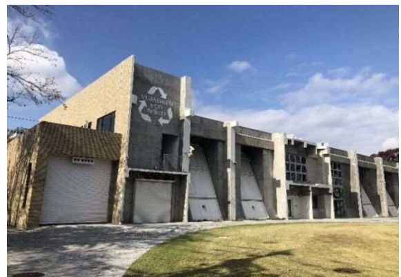
▲ むさしのエコreゾート外観
