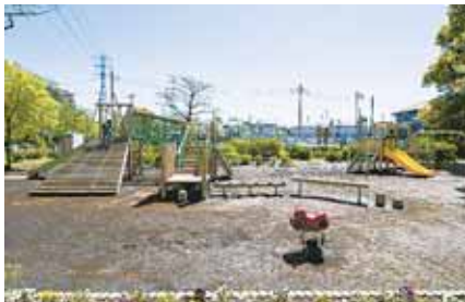
公園改修事例（上水南公園）
