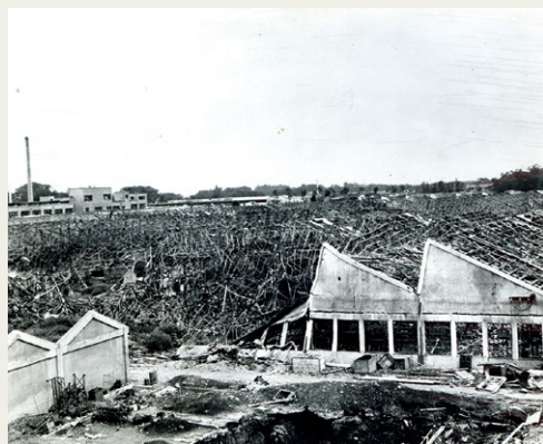
爆撃後の中島飛行機武蔵製作所東工場。 (米国国立公文書館原蔵)
