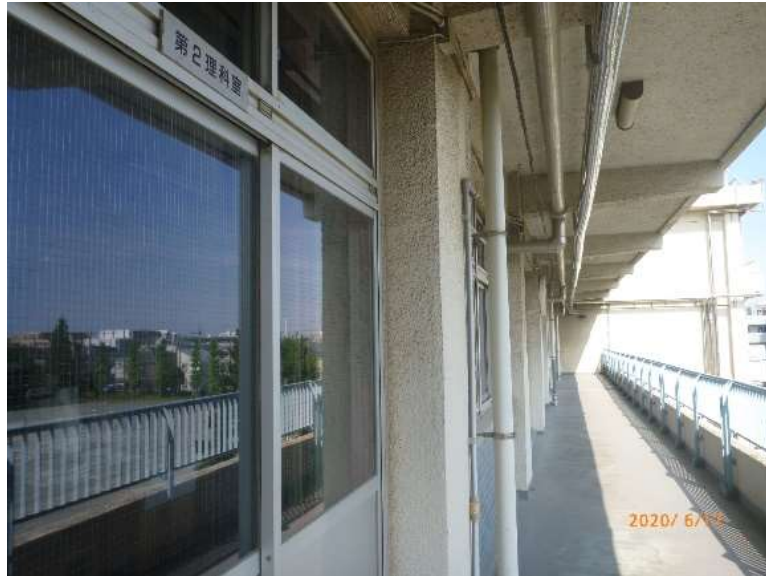
西校舎外廊下
