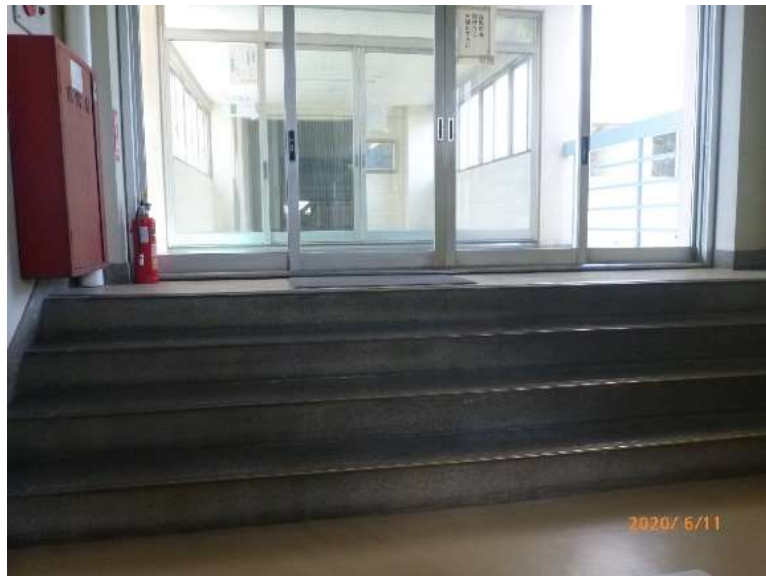
西校舎体育館棟接続部
