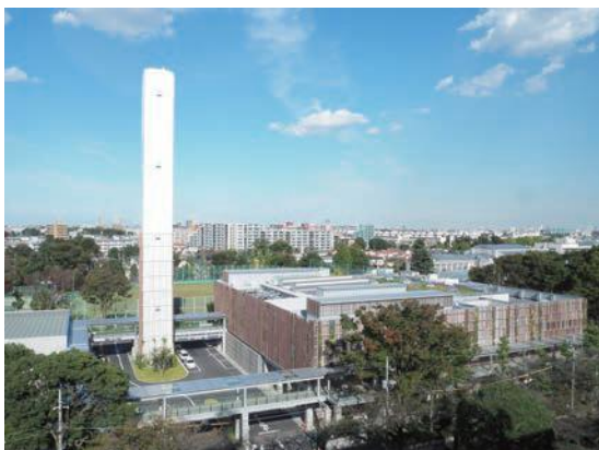
武蔵野クリーンセンター
