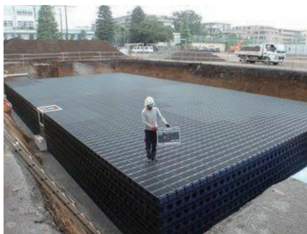
雨水貯留・浸透施設設置工事の様子
