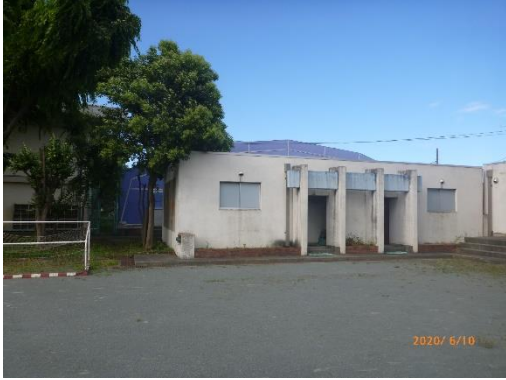
プール更衣室棟
