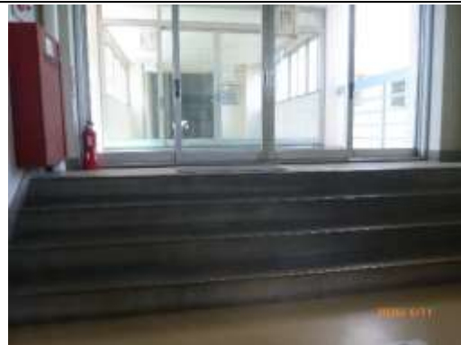
西校舎体育館棟接続部
