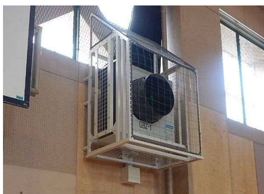
▲ 市立小中学校体育館に設置されている冷暖房機器 (コミュニティセンター体育施設に設置する機器のイメージ)
