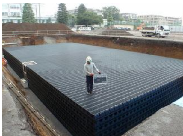
雨水貯留・浸透施設設置工事の様子
