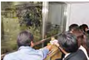
gomi_pit BAR(ごみピットバー)の様子
