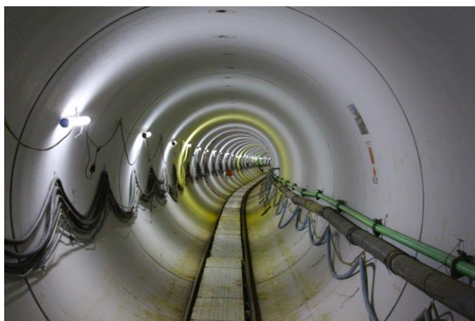
石神井川排水区雨水排水幹線
