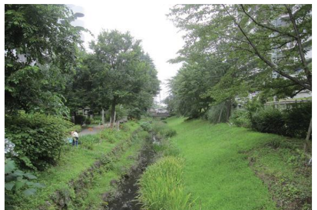
コンクリート護岸から自然護岸に改修された仙川（一部区間）
