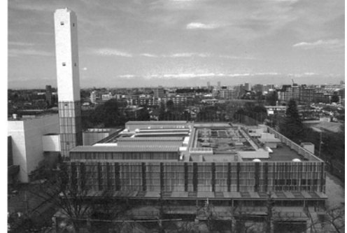
新クリーンセンター（平成29年4月～）緑町3-1-5
