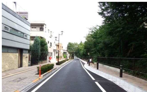
▲整備事例(市道第12号線)
