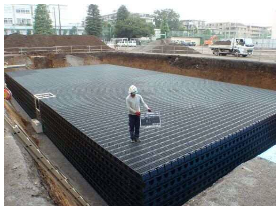
▲雨水貯留浸透施設の設置の様子
