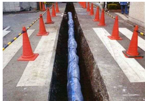
▲配水管更新工事
