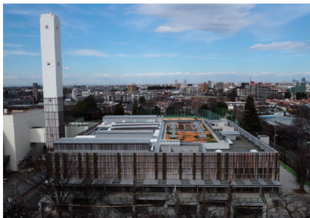
武蔵野クリーンセンター
