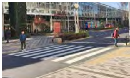
歩歩道の段差を小さくし、通行しやすいスムーズ横断歩道に改修(3カ所)。施工例:武蔵境駅北口
