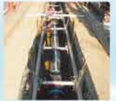
配水管更新工事の様子
