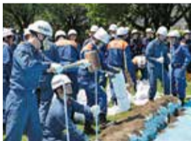
積み土のう工法
