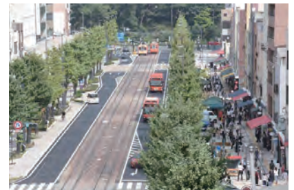
松山市 花園町通り*（6車線から2車線への道路空間の再配分や無電柱化）
