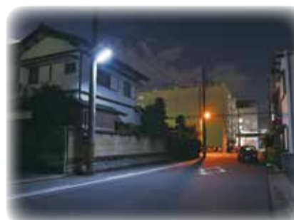
LED化された小型街路灯
