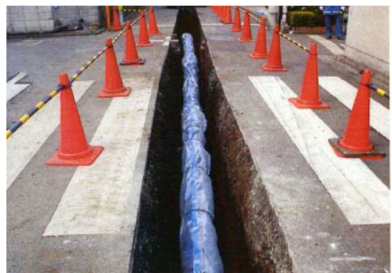
▲配水管更新工事の様子
