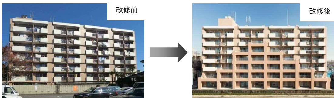
▲特定緊急輸送道路沿道建築物の耐震改修工事例
