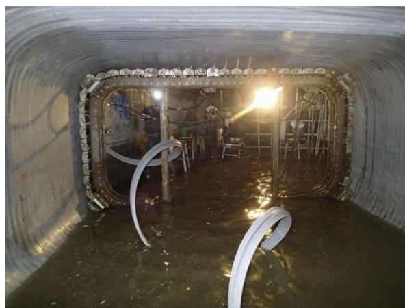
女子大通り幹線更生工事の様子
