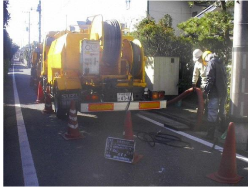
下水道管きょの清掃の様子
