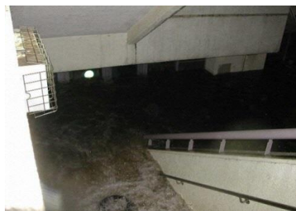
市内での浸水被害状況(平成17年9月4日 日北町コミュニティーセンター地下)
