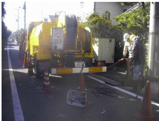
下水道管きよの清掃の様子
