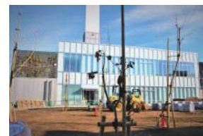
工事中のどんぐり広場
