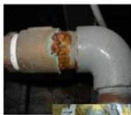
給水管継ぎ手の劣化状況
